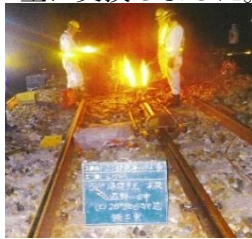
レール交換作業
