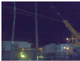
コンクリート柱建替え 1
