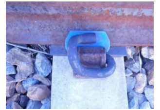
締結装置パンドロール型
