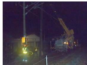
コンクリート柱建替え 2
